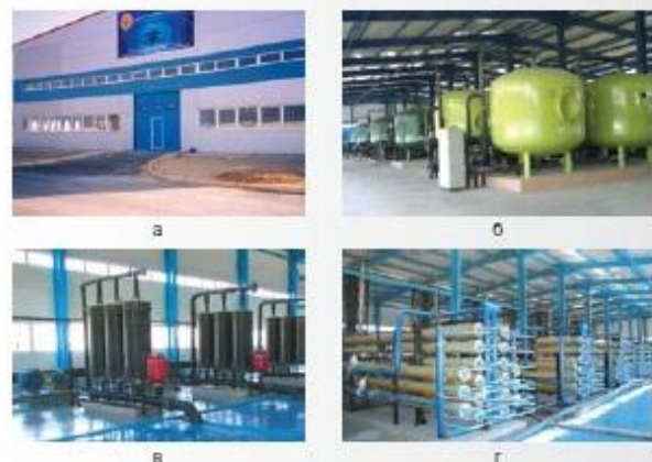
Рис. 1. Мангистауский опреснительный завод производительностью 10 тыс. м 3 /сутки питьевой воды: а – общий вид, б – участок предварительной подготовки морской воды, в – участок микрофльтрации, г – обратноосмотические установки.
