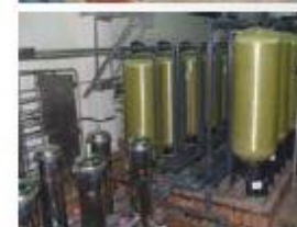
Рис. 6. Комплекс получения деионизованной воды на промышленной установке по получению водорода на АО «Павлодарский нефтехимический завод», Республика Казахстан
